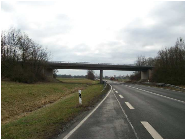
Abbildung 18: Brücke im Zuge der Anschlussstellenrampe Koltzheim – Schweinfurt über die B 286, ASB Nr. 6027 505, in Fahrtrichtung Gerolzhofen
