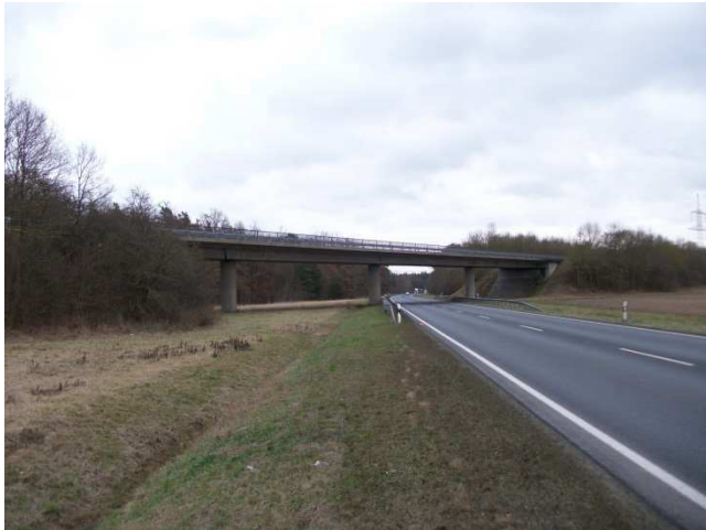
Abbildung 16: Vorhandenes Überführungsbauwerk St 2271 Unterspiesheim – Schwebheim, ASB Nr. 6027 503, in Fahrtrichtung Gerolzhofen
