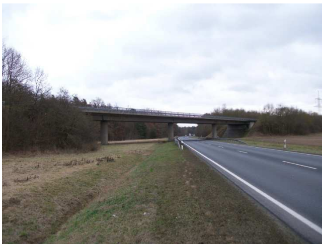
Abbildung 4: Brücke im Zuge der St 2271 Unterspiesheim – Schwebheim über die B 286, ASB Nr. 6027 503, in Fahrtrichtung Gerolzhofen
