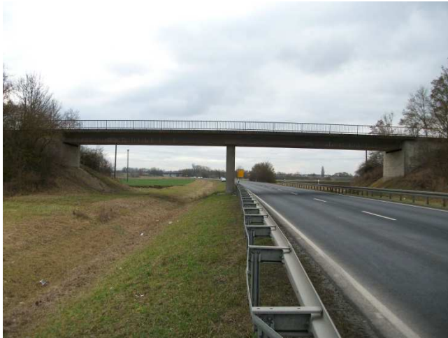
Abbildung 5: Brücke im Zuge der GVS Unterspiesheim – Grettstadt über die B 286, ASB Nr. 6027 504, in Fahrrichtung Gerolzhofen
